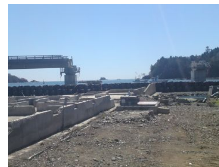
巨大防潮堤の建設が議論されている南三陸町歌津。写真は津波によって破壊された歌津大橋の様子です。
